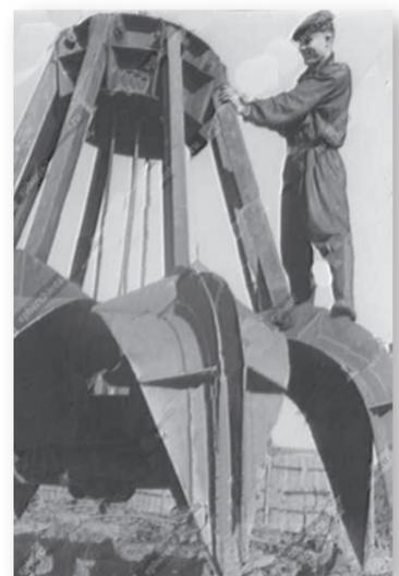
Рабочий торфоразработок за регулировкой грейфера - машины для погрузки торфа. Фото 1930 г.
